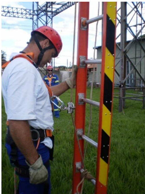
Figura 2 - Fixação com sistema trava queda em linha de vida na escada Fonte: Autor
